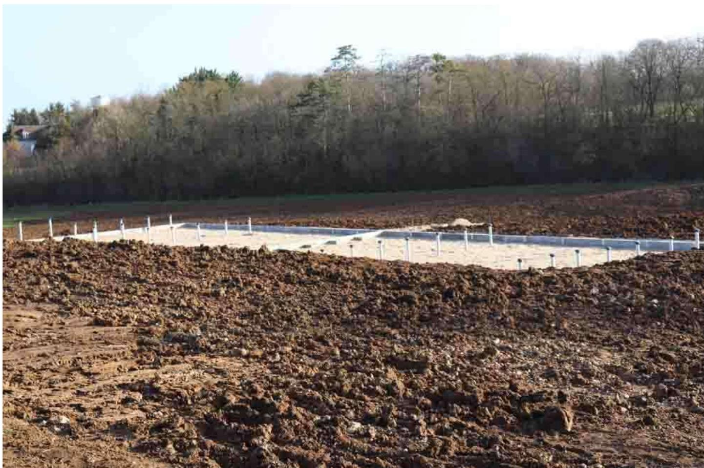
Mise en place des graviers du 1er étage de filtration
