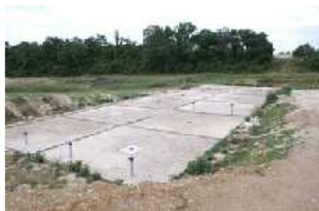
Les bâchées vont jaillir au centre des carrés de sable et s'infiltrer lentement dans 80 cm d'épaisseur de sable. Cette dernière étape, pour un fonctionnement optimal, nécessite un ratissage hebdomadaire de la couche supérieure du sable par l'employé communal. La plantation de roseaux (*Phragmites australis*), en octobre 2013, va permettre de fragmenter naturellement le sable et éviter cette opération manuelle.
